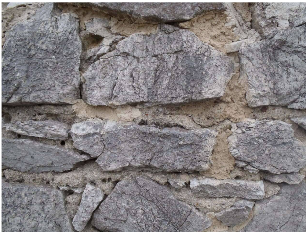
Obr. 9. Detail neomítaného zdiva hradu Rabí v průběhu doplňování zdicích malt do spár zdiva. Nově doplněné malty jsou při detailním pohledu nepatrně světlejší a jsou doplněny jen v místech, kde je to nezbytně nutné. Tím je i pro další generace uchována výpovědní hodnota zdicí malty v tomto úseku.
