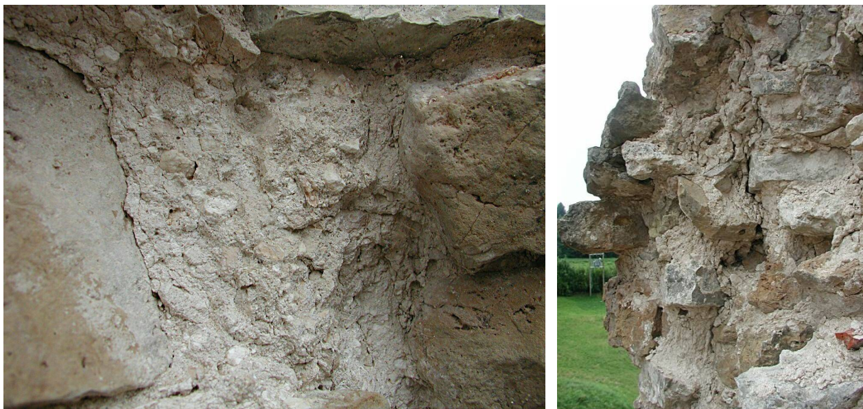
Obr. 3 a 4. Hrad Bauska, Lotyšsko, zdicí malta vnějšího opevnění s patrnými oblými vměstky nerozmíchaného vápna v tzv. horké maltě. Detail zdiva s rozpadající se zdicí horkou maltou.
