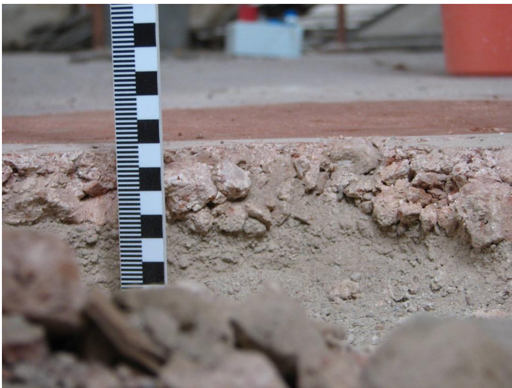
Obr. 7 Detail lomu vápennou podlahou, severní palác SH Švihov. Současně je patrný očištěný povrch podlahy, který je růžový.
