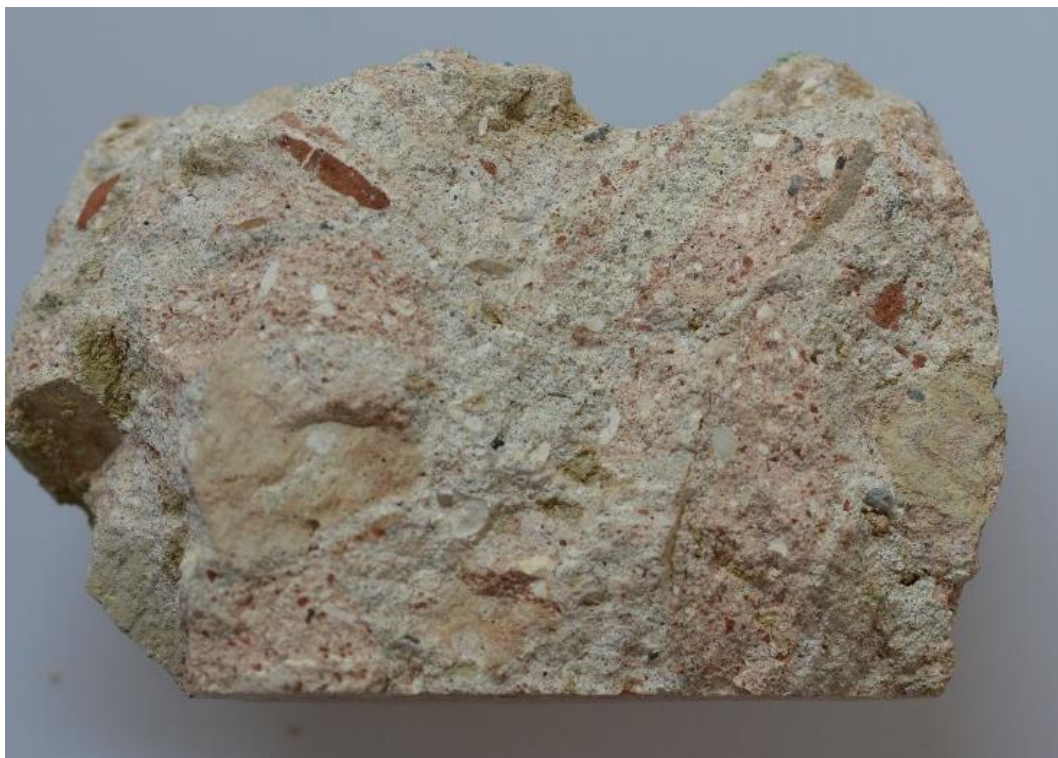
Obr. 14 Úlomek zaniklé podlahy na terase sala terreny SZ Lysice. V maltě jsou patrné úlomky starší maltové podlahy.
