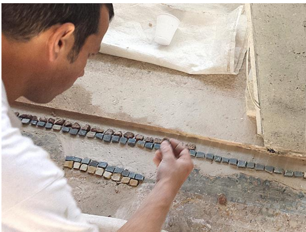
Obr. 13 Vkládání (sázení) rámování při opravě teraca.
